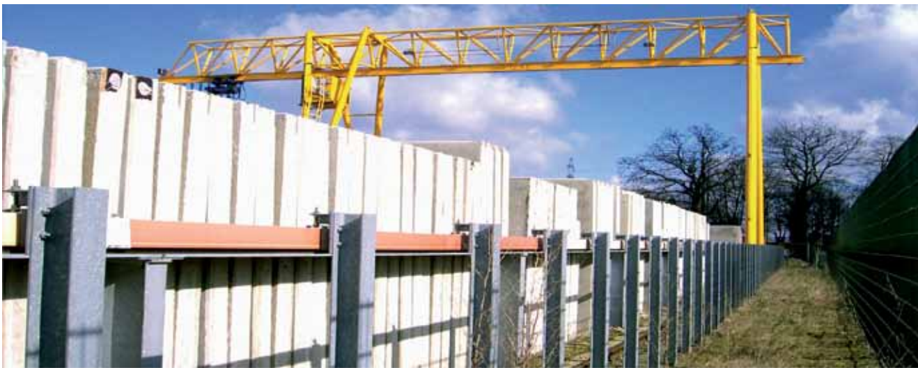
Токопровод 120 м. для питания мостового крана в бетонном производстве
